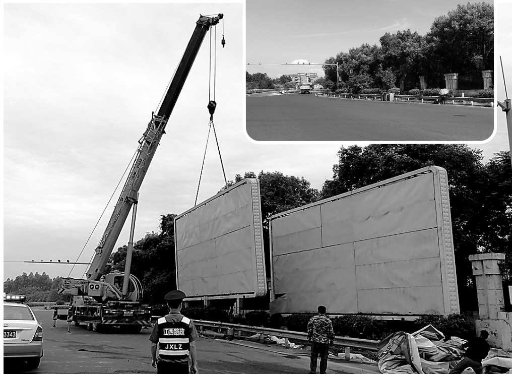
6月12日,赣定高速公路南康收费站附近的广告设施被全部拆除。
