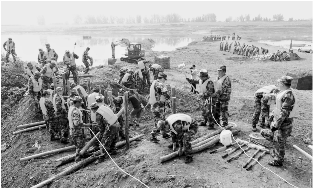
日前,锦州市有关部门在小凌河古塔区段开展抗洪抢险实战演练,确保汛期有情况“拉得出、用得上、起作用”。图为抢险救援人员在抢修堤坝。
