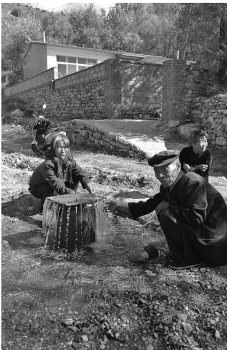
施工人员在建昌县小德营子乡双榆树村钻井打出了一口“喷泉”,村民在接水。
