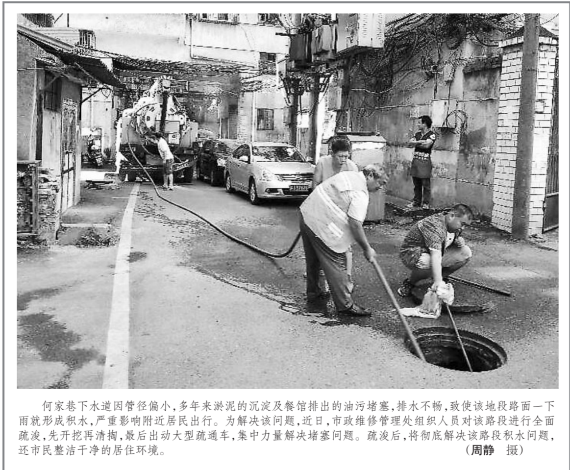
何家巷下水道因管径偏小,多年来淤泥的沉淀及餐馆排出的油污堵塞,排水不畅,致使该段路面一下雨就形成积水,严重影响附近居民出行。为解决该问题,近日,市政维修管理处组织人员对该路段进行全面疏浚,先开挖再清掏,最后出动大型疏通车,集中力量解决堵塞问题。疏浚后,将彻底解决该路段积水问题,还市民整洁干净的居住环境。(周静 摄)
