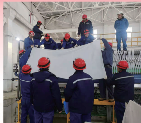
图为技术人员在安装离子膜
