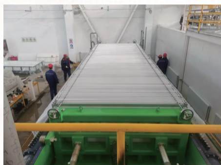
图为单台电解槽总览
