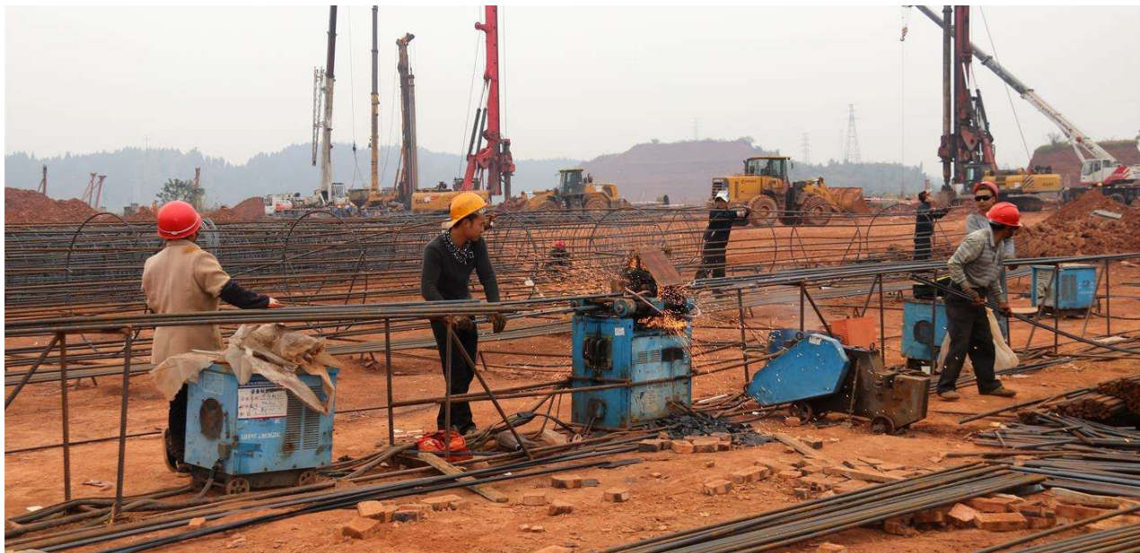
光电产业园标准厂房一期加紧施工
