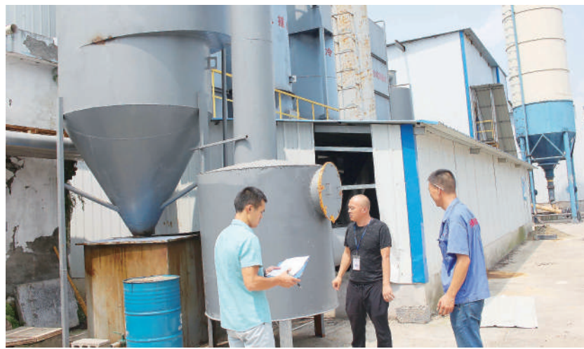
大英县环保局执法人员对企业废气收集、治理设施进行现场检查
