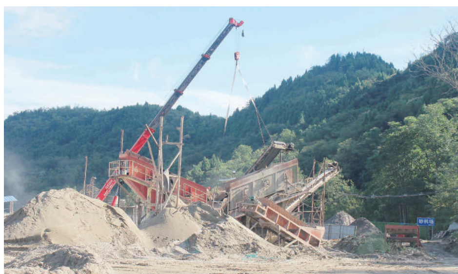
根据中央环保督察整改和省“散乱污”企业治理要求,我县将拆除51个砂石场。截至9月28日,已经拆除19个,其余砂石场也在陆续拆除中。图为9月28日,瞿河乡乌木桩砂石场正在有序拆除。 全媒体记者 李晓玲/摄
