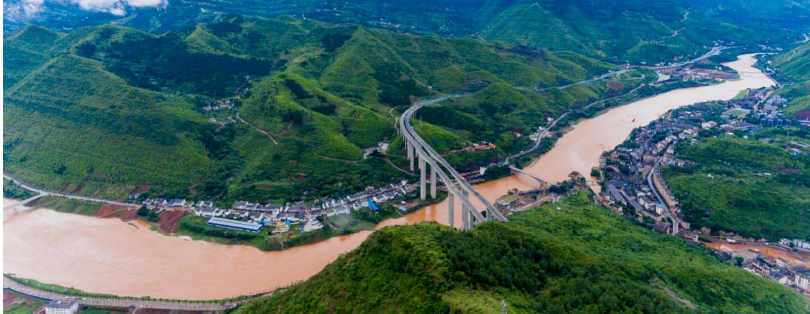
赤水河习水土城段航拍图 王庆/摄
